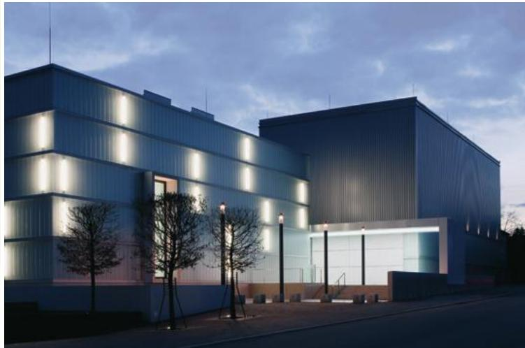
элементом оформления внешней конструкции здания являются профильные строительные стекла Pilkington **Profilit™**, инсталлированные в виде однорядной навесной вентилируемой конструкции перед бетонными стенами с помощью теплоизоляционной крепежной системы. Более низкая новая постройка, граничащая с бывшим высокостеллажным складом, эффектно выглядит по ночам благодаря фрагментальной вертикальной вмонтированной подсветке в отдельных сегментах профильных стекол.
